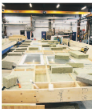
▲ Parocin sitoutuneisuutta kehittää energiasaneerausta teolliseen suuntaan kuvaa se, että se lahjoitti kohdetaloon tarvittavat eristeet.
